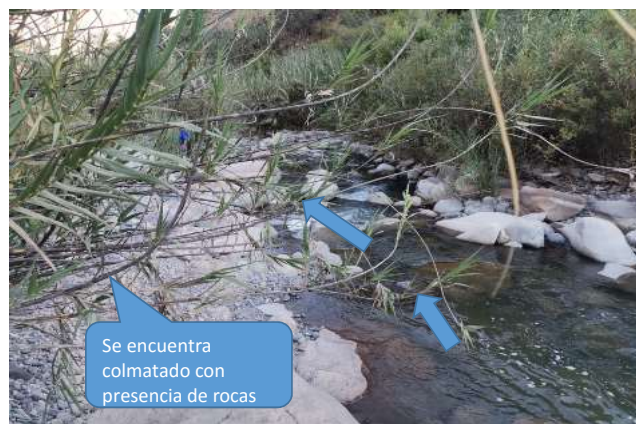
FIGURA N°02: TRAMO DEL CAUCE DEL RIO CHANCAY - HUARAL CON DIQUE DE MATERIAL PROPIO EN MAL ESTADO, EN EL SECTOR SAN MIGUEL DEL DISTRITO DE HUARAL.
