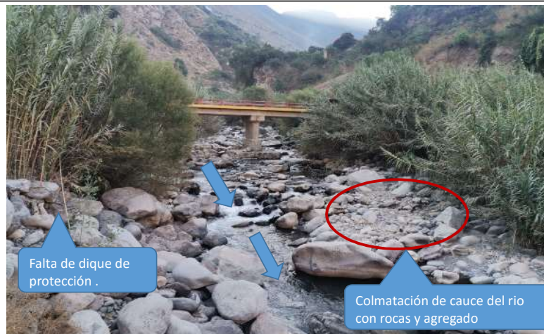
FIGURA N°04: SE REDUCCIÓN LA SECCIÓN HIDRÁULICA DEL RIO EN EL SECTOR DEL PUENTE OCHENDO Y COLMATADO CON PRESENCIA DE ROCAS
